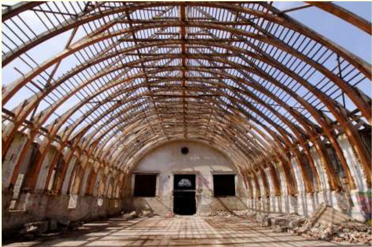
Basedow, Reithalle, Blick in die Dachstuhlkonstruktion
