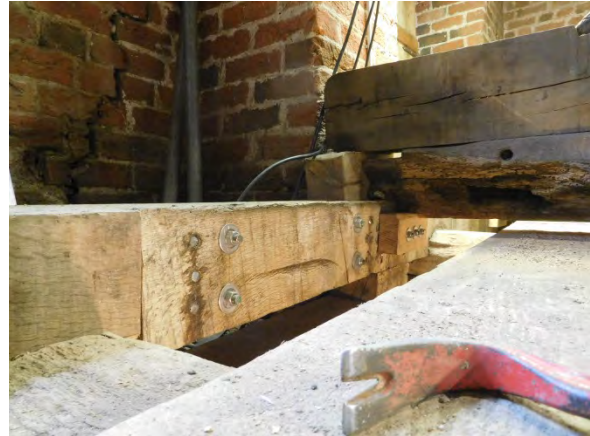
Detail saniertes Holzkonstruktion / Auflager Glockenstuhl
