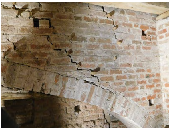
Bogen in der Ostwand des Turmes während der Sanierung
