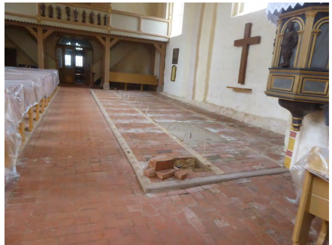
Nordseite Bänke demontiert
