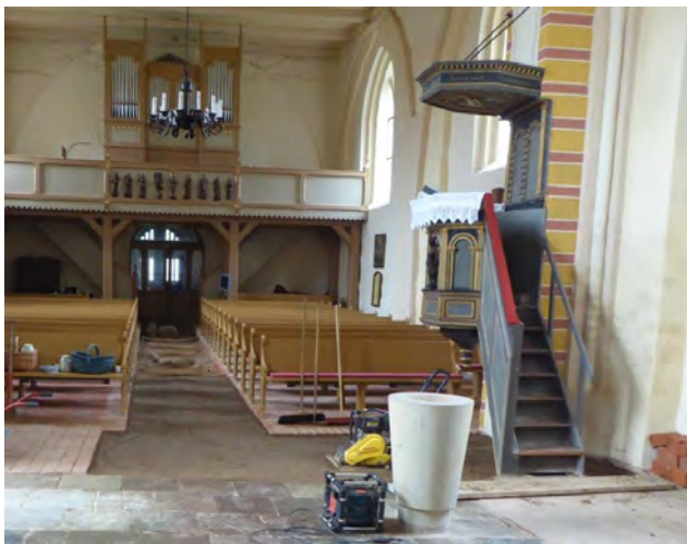
während der Ausführung Mittelgang
