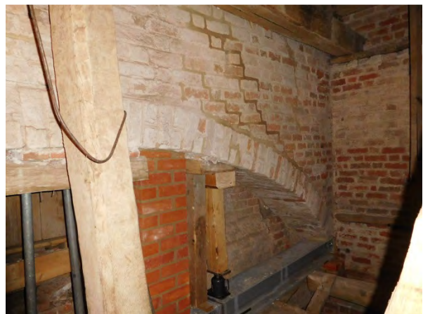
Bogen nach Fertigstellung mit Untermauerung sowie Auflager, Stahlträger
