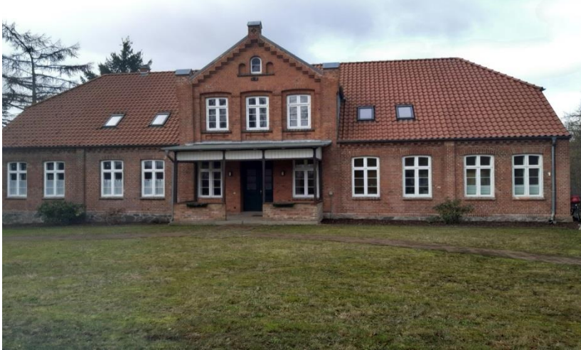
Abb. 10: Vorderansicht des Pfarrhauses Gresse mit sanierter Fassade
