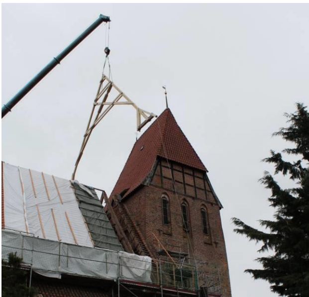
Abb. 6: „Einschweben“ des ersten neuen Gebindes
