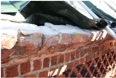
Abb. 23-25: Wiederherstellung Mauerwerksgesims mit neuen Formziegeln
