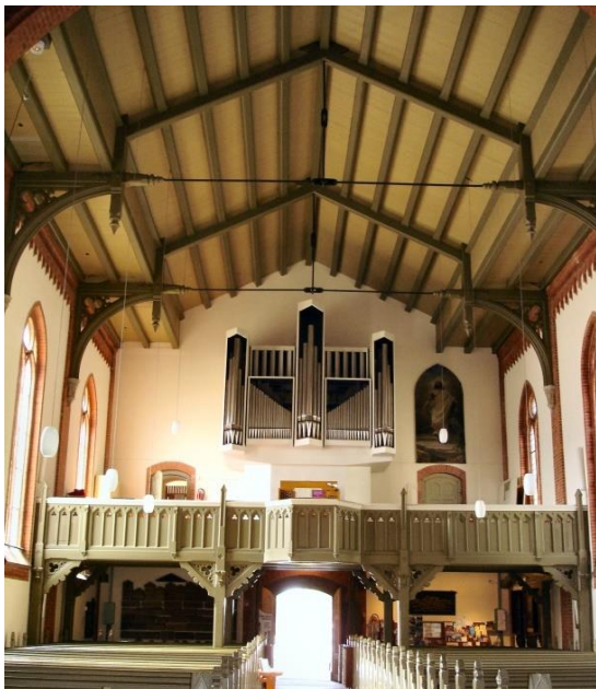
Abb. 2: Kirchenschiff mit alter Beleuchtung
