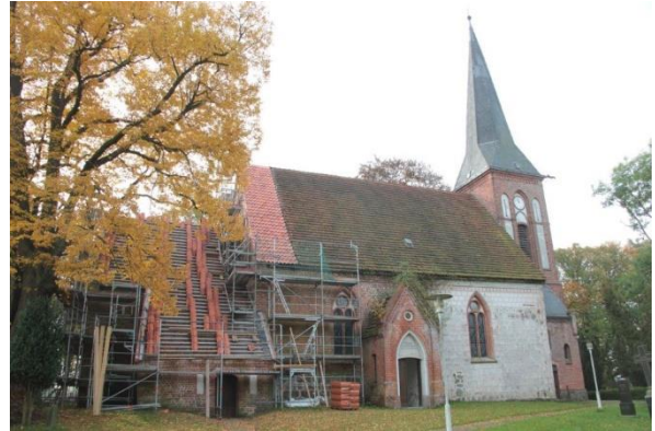
Abb. 18: Sanierung der Kirche Lübsee
