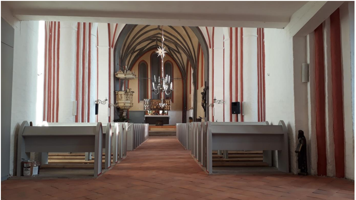
Abb. 8: Blick auf den Altar der sanierten Kirche St. Bartholomäus Wittenburg
