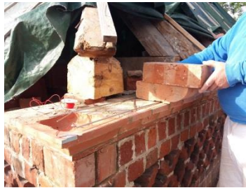
Abb. 23-25: Wiederherstellung Mauerwerksgesims mit neuen Formziegeln
