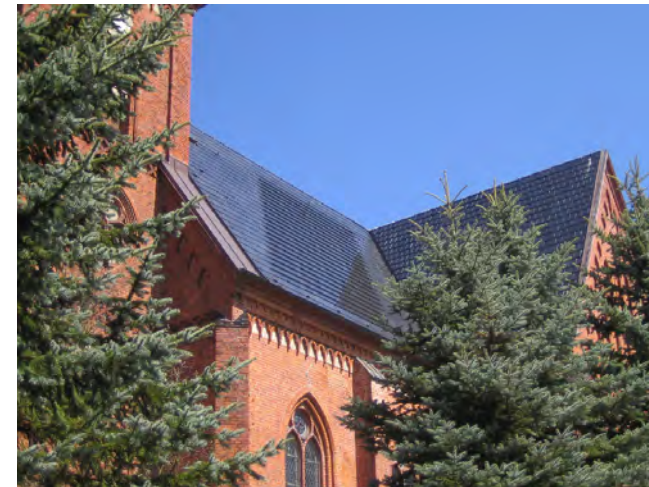
Fotovoltaikanlage Kirche Carlow
