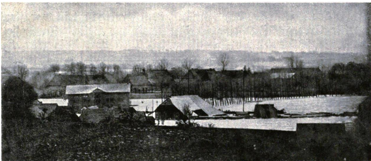
Abb. 10: Blick auf Callies Speicher – Sturmflut v. 12.11.1872
