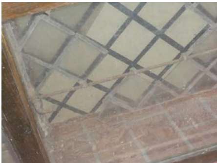
Schadhafte Bleiverglasungen.
