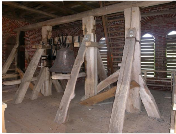
Der Glockenstuhl mit Georgenglocke in der Mitte
