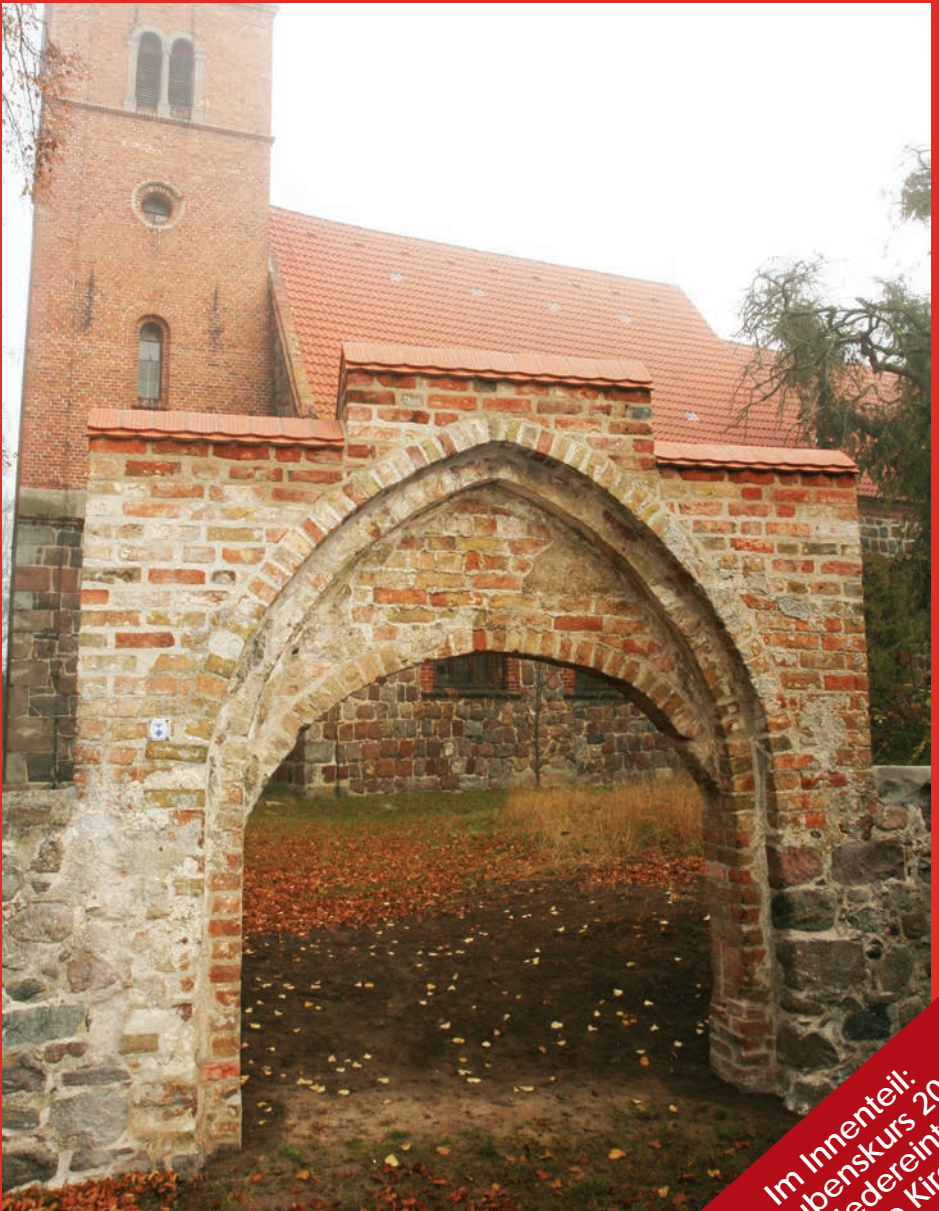
Saniertes Kirchhofstor in Radekow
